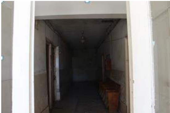
Platan, 1. katu (Kortin ja laitehuoneiden vuorokausi)
