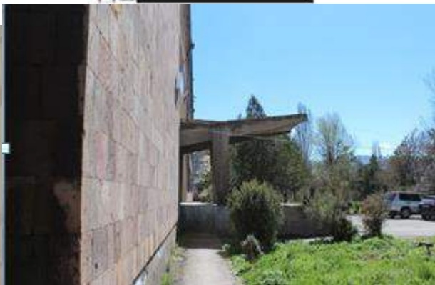
Platan, 1. katu (Kortin ja laitehuoneiden vuorokausi)
